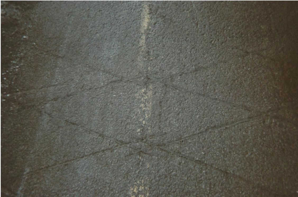
**Figure 31 : Chaussée avec marquage de déneigeuse**
