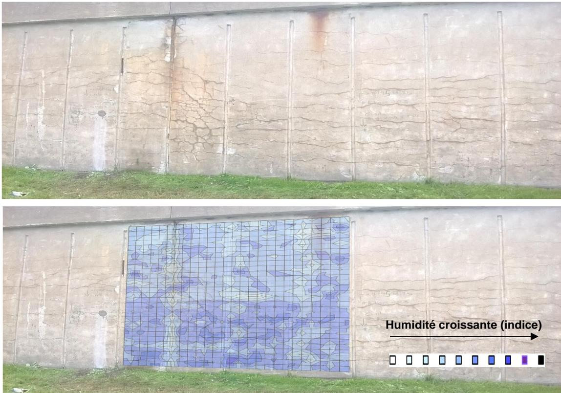
**Figure 2.8** Aspect général d'un mur de soutènement (en haut) et distribution spatiale de l'humidité superficielle relative du béton obtenu par capacimétrie électrique (en bas) (Crédit SETEC).
