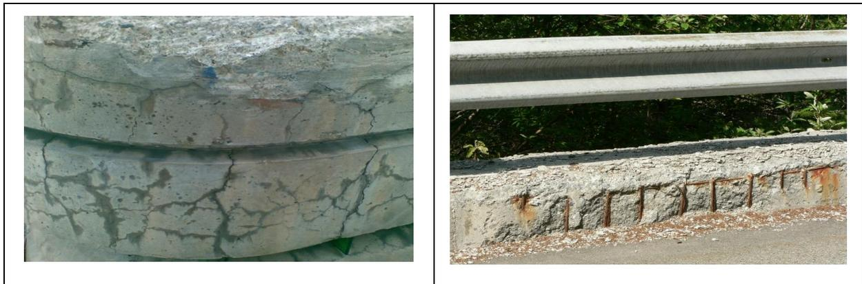
Figure 2.4 Illustration des conséquences de cycles répétés de gel-dégel (Crédit SETEC).
