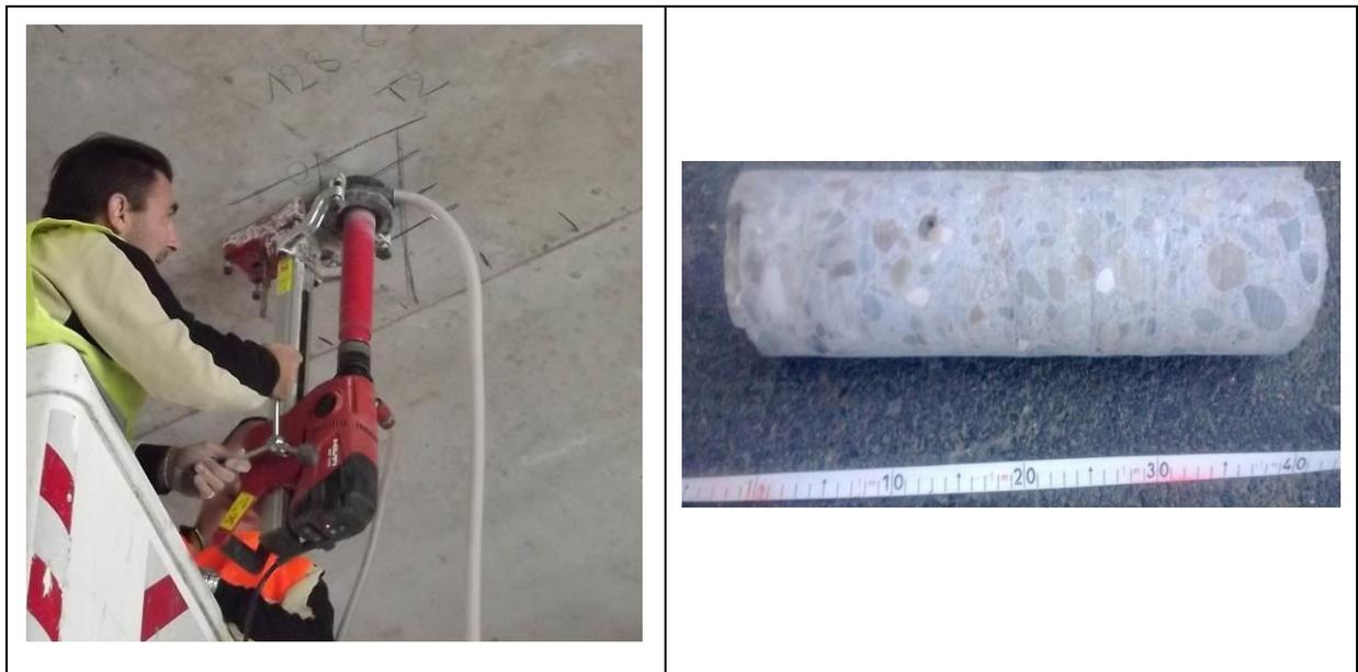
**Figure 2.16** Carottage réalisé en sous-face d'un tablier de pont (à gauche) et carotte de béton associée (à droite) (Crédit SETEC).
