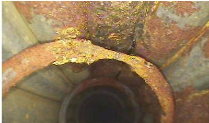
**Figure 2.10** Photographie extraite d'une acquisition par vidéo-endoscopie réalisée à l'intérieur d'une gaine de précontrainte (Crédit SETEC).
