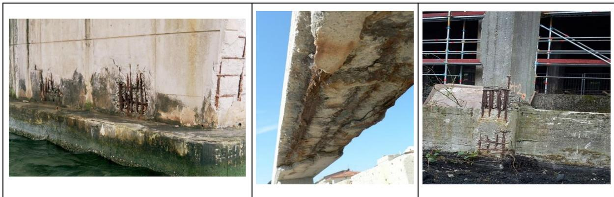
**Figure 2.2** Illustration des conséquences du phénomène de corrosion des armatures en environnement marin (Crédit SETEC).
