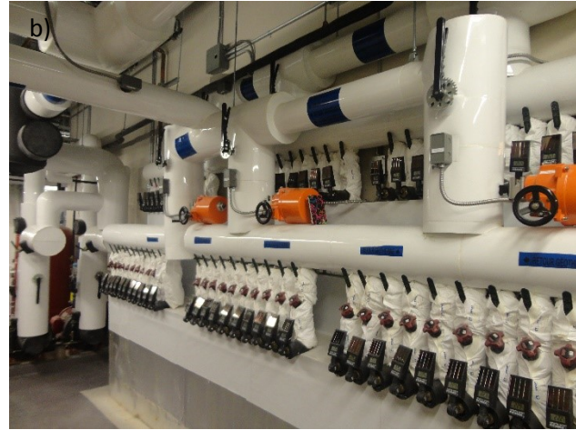
Figure 23. Une image de la cours et des puits géothermiques dans la salle mécanique de l'École Carignan-Salières.
