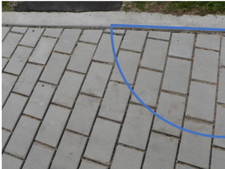
**Figure 4.2** Section de pavage perméable partiellement colmatée par les apports d'une surface connexe
