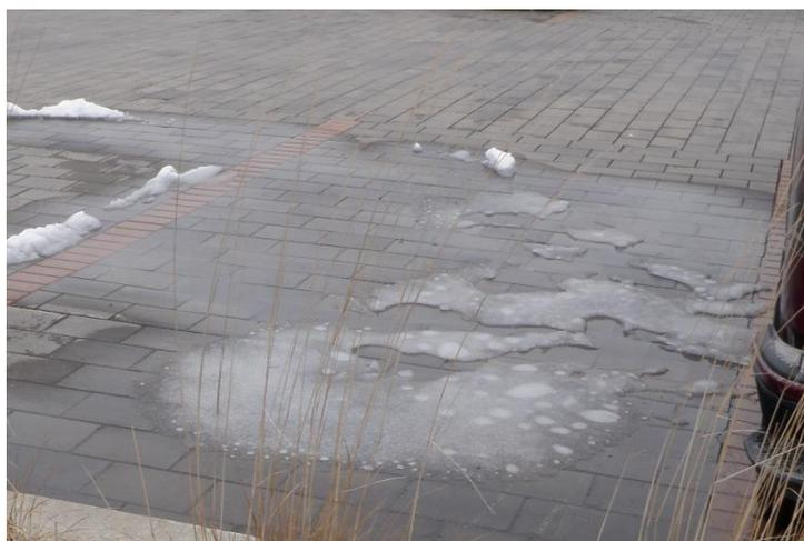
**Figure 4.4** Accumulation de l'eau de fonte sur le pavage traditionnel non perméable
