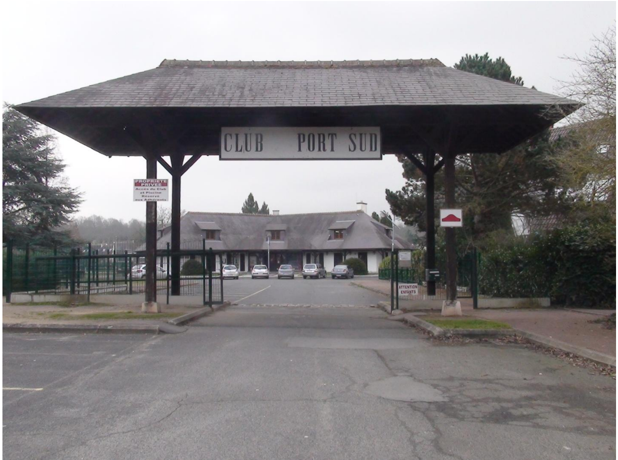
Figure 4.3.2.c Photographie de l'entrée principale du Club de Port-Sud
