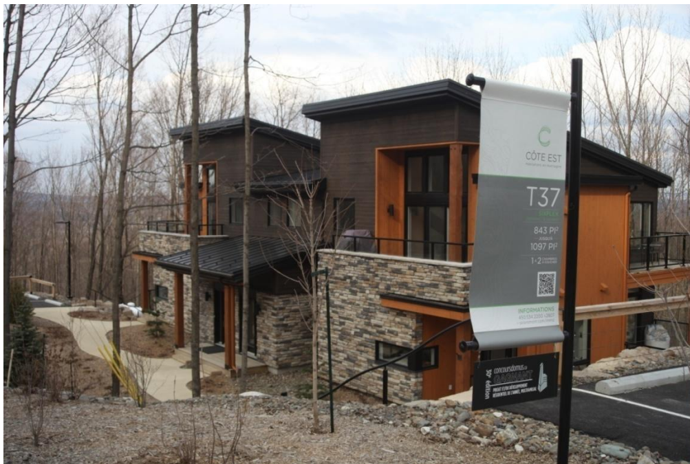
Figure 7.3.f Exemple de projet immobilier construit par ski Bromont
