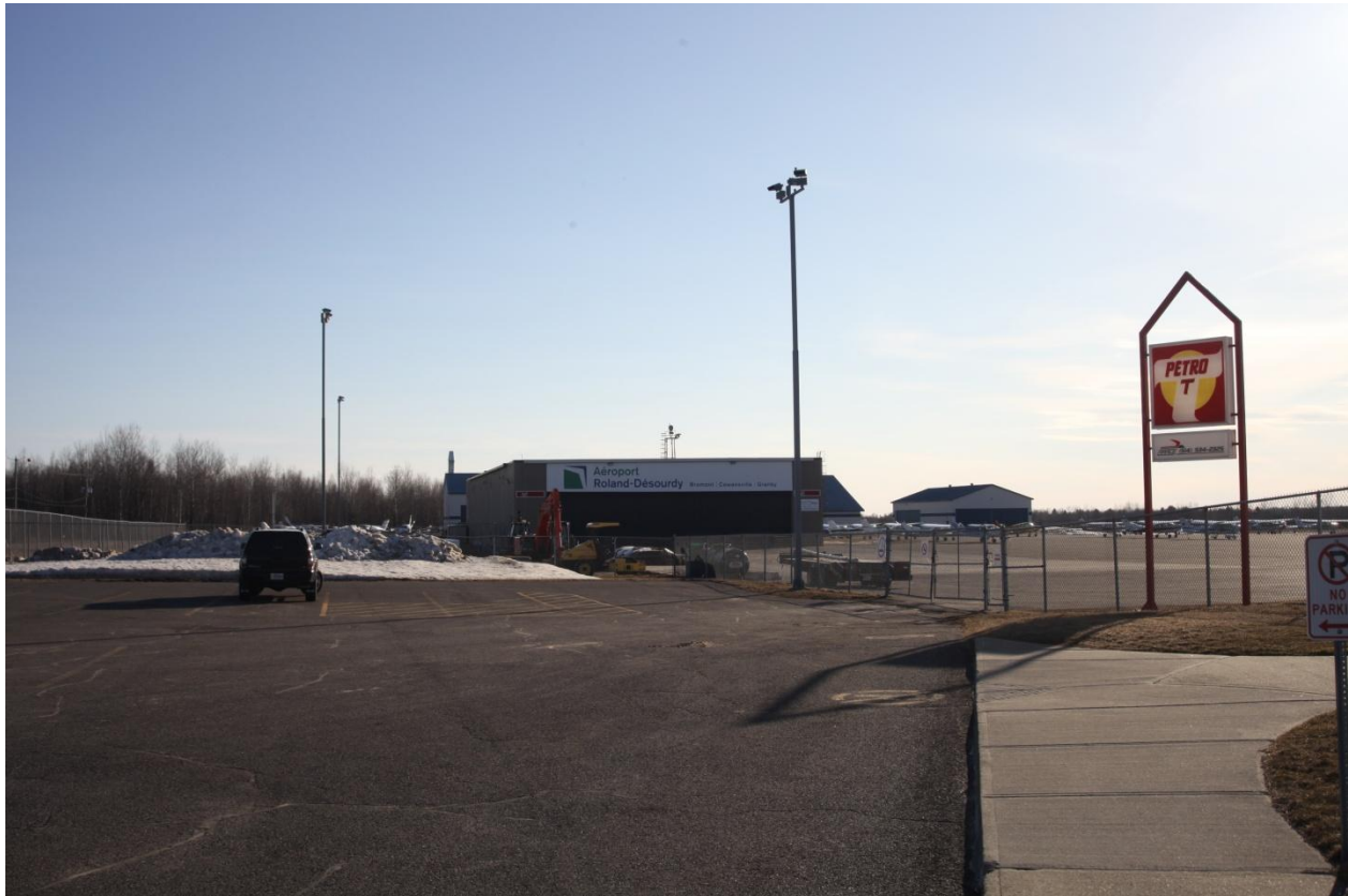
Figure 4.4.1.2.b Photographie de l'aéroport Roland Désourdy
