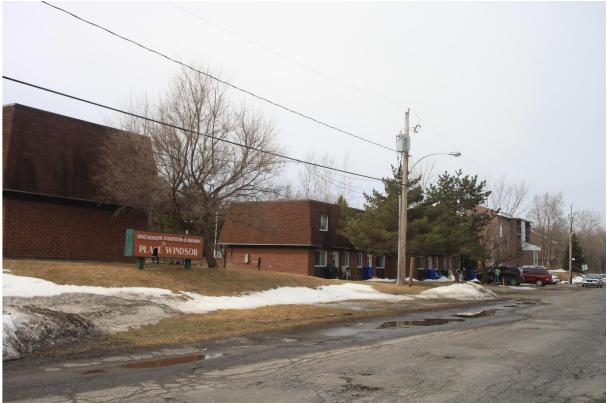
Figure 4.4.2.c Photographie de la "place windsor" seule réalisation du projet tardif de Bromont en faveur d'une prise en compte du "besoin habitant"
