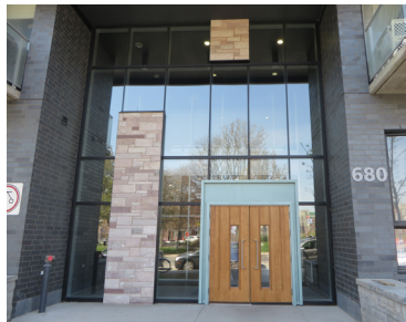
Entrée des copropriétés
