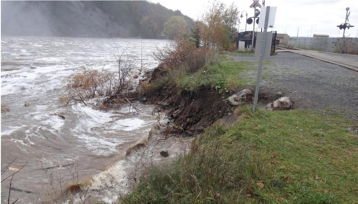
**Figure 55 : Érosion active jouxtant la voie ferrée derrière le poste d'accueil de la SÉPAQ (photo prise par l'auteur lors de la crue du 3 novembre 2017 (650 m<sup>3</sup>/s))**
