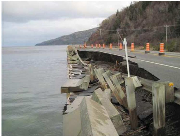
FIGURE 1.1: Exemple de défaillance d'un mur côtier.
