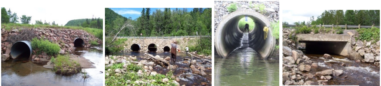
Figure 6: Sites d'étude : les ponceaux Résimond, Morin, Palmer et Allaire
