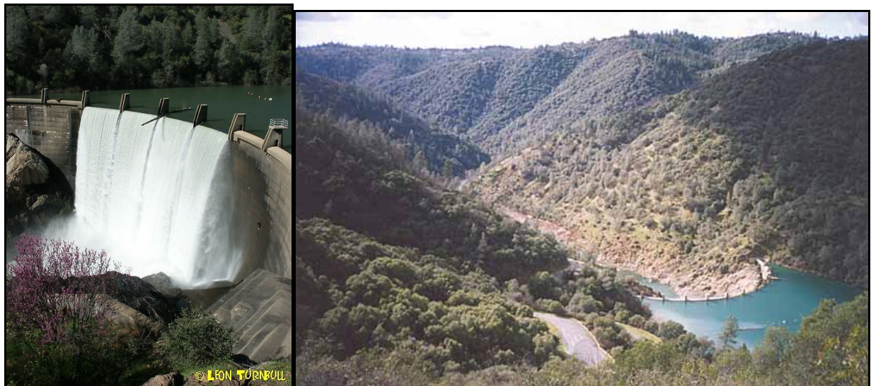
Figure A2.5 : Photos du barrage North Fork et du lac Clementine
