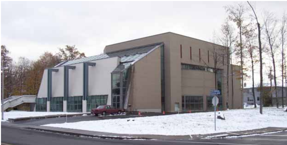
7. Projet de mosquée dans une ancienne synagogue (Dollard-des-Ormeaux)
