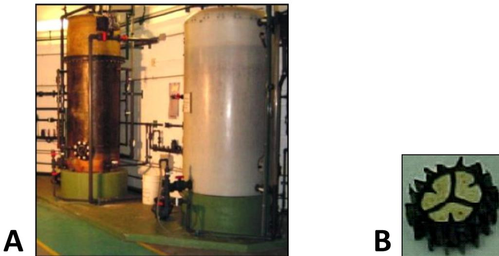
**Figure 1.2** : Photos du système de dénitrification du Biodôme de Montréal. (A) Désoxygénateur (à droite) et dénitrificateur (à gauche); (B) Photo d'une biobille de type Bioflow 9<sup>®</sup> sur laquelle s'est développé un biofilm.
