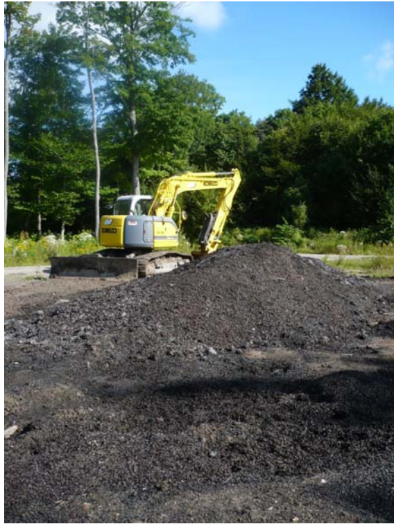
Figure 26 Pile T2 et pelle-mécanique utilisée pour les essais à grande échelle
