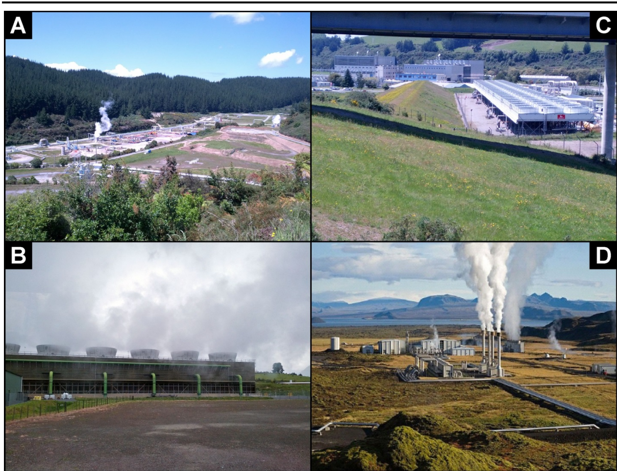
Figure 3 – Exemples de centrales géothermiques. A : Installations de conduits au sol près de la centrale de Wairakei, Nouvelle-Zélande. B : Tours de refroidissement, centrale de Rotokawa, Nouvelle-Zélande. C : centrale de Wairakei, Nouvelle-Zélande. D : centrale de Nesjavellir, Islande. Sources : A, B, C - photos de Michel Malo; D - https://commons.wikimedia.org/wiki/File:NesjavellirPowerPlant_edit2.jpg
