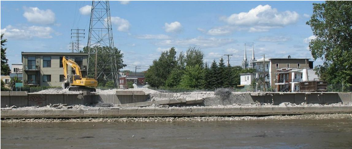
**Figure 60** : Travaux de destruction des murets en béton pour la renaturalisation des berges de la rivière Saint-Charles, à Limoilou, en 2006 (source site Ville de Québec).
