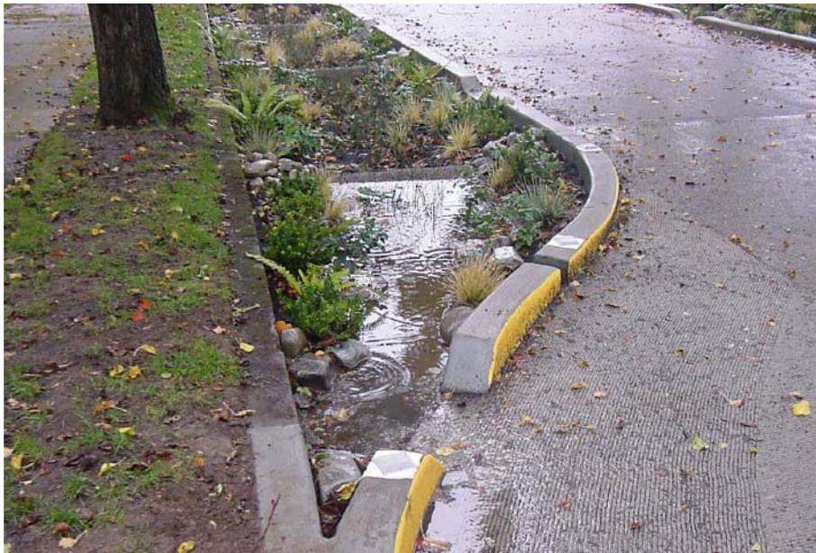
**Figure 5.23** Exemple d'aménagement de rues résidentielles permettant d'augmenter l'infiltration.
