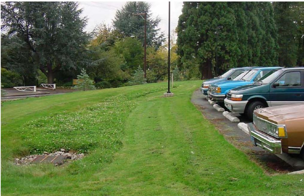
**Figure 5.24** Exemple d'aménagement de bandes filtrantes et de fossé de rétention pour un stationnement.
