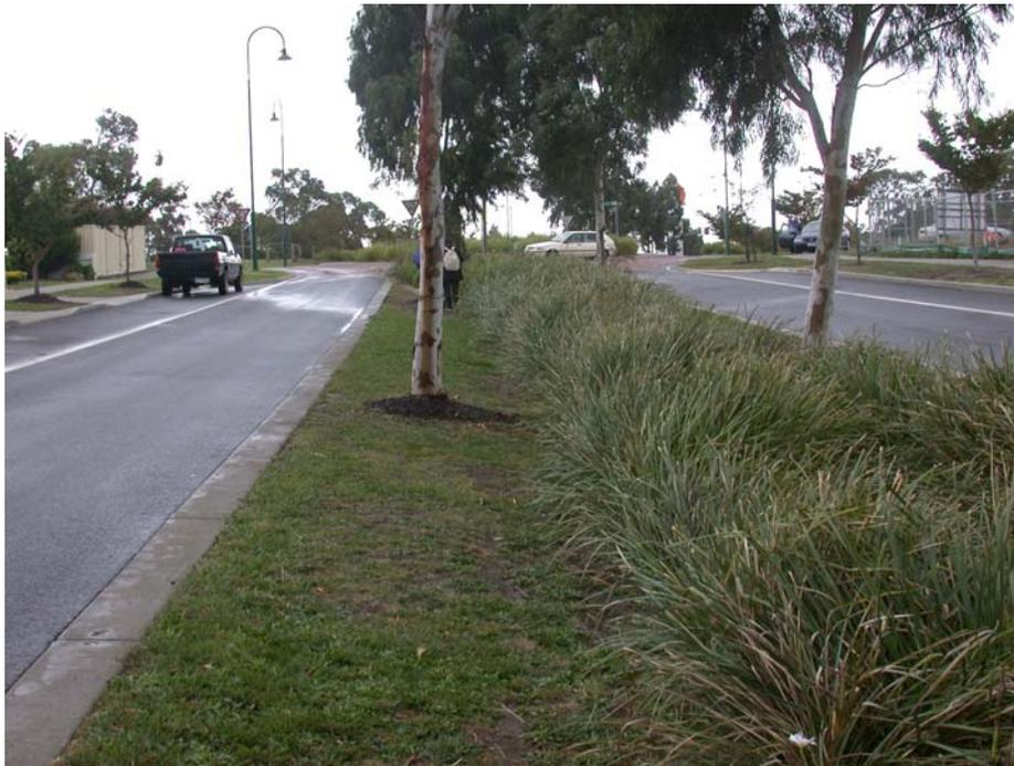
Figure 5.21 Fossé aménagé avec biofiltration dans un terre-plein de boulevard.
