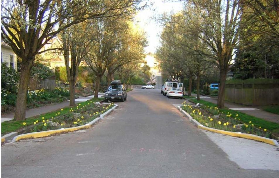
**Figure 5.22** Aménagement de rues résidentielles pour maximiser le contrôle à la source et l'infiltration.
