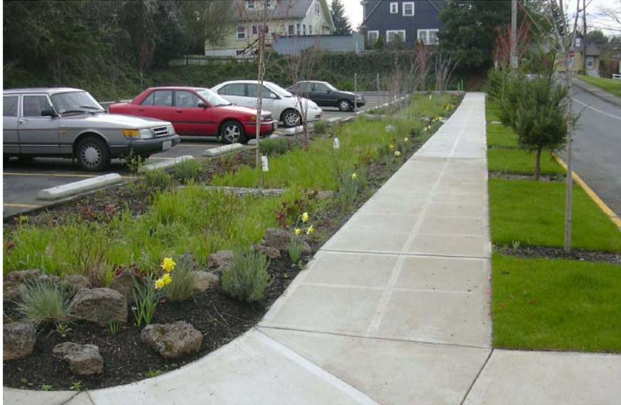
**Figure 5.25** Exemple d'aménagement de fossé de rétention pour un stationnement (avec biofiltration).
