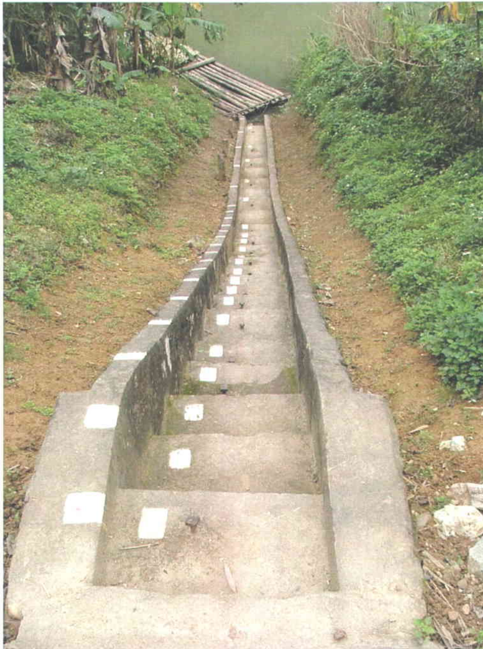
Figure A-34 : Dispositif de mesure du niveau d'eau à Thac Rieng.
