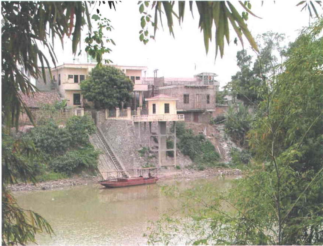
Figure A-35 : Dispositif de mesure du niveau d'eau à Gia Bay.
