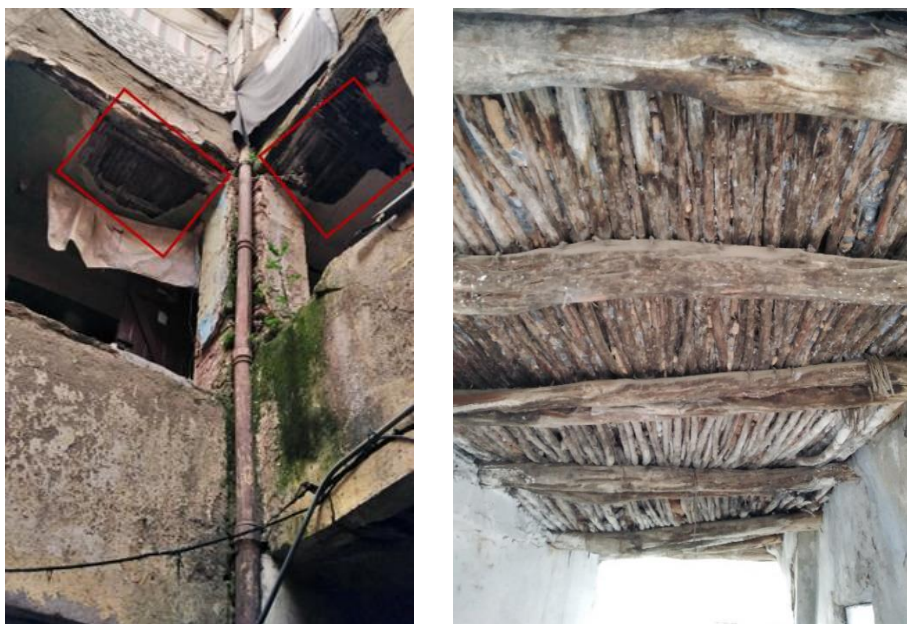
Figure 3.5 : Photos montrant le bois de genévrier comme matériaux de construction
