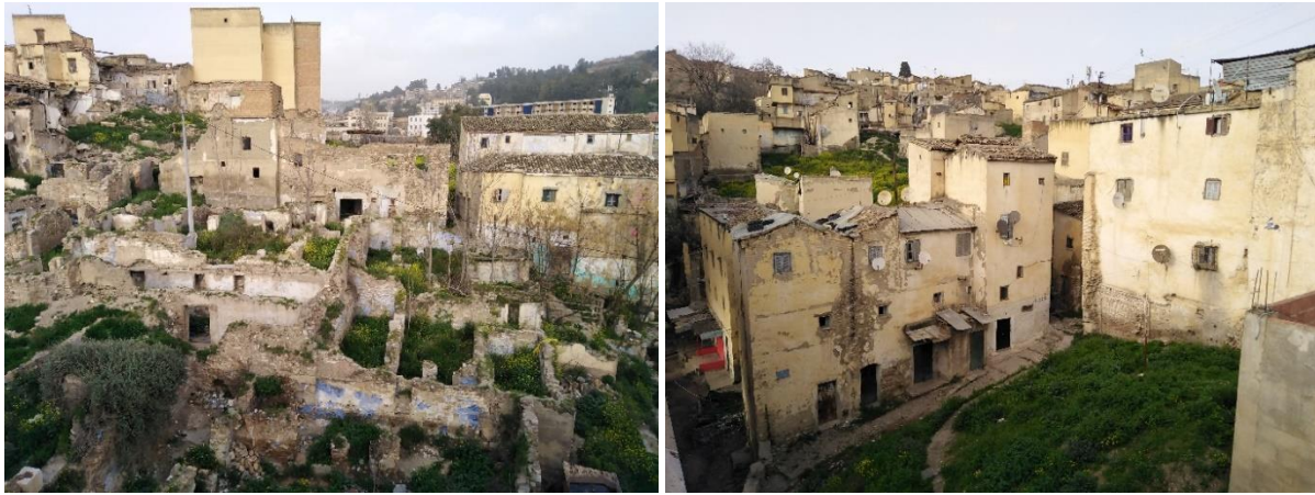
Figure 3.3 : Vue d'ensemble de Souika à partir du pont Sidi Rached
