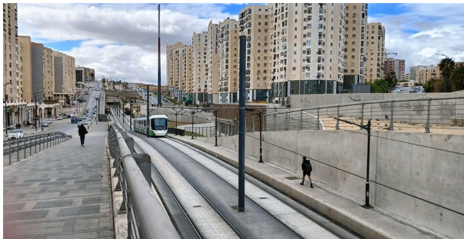
Figure 5.3 : Photo montrant le tracé du tramway longeant le boulevard de l'Armée de libération nationale, appelé « El Istiqlal » 135
