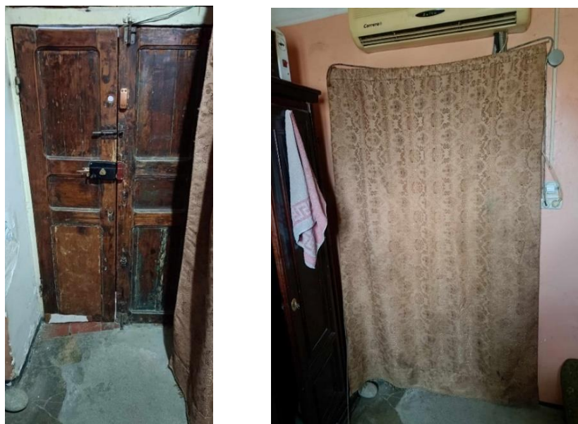
Figure 3.16 : Photo d'une « kella » en guise de porte d'entrée d'une chambre d'une maison à Souika
