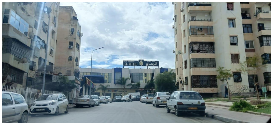
Figure 4.5 : La façade principale du centre El Ritedj à l'UV 06
