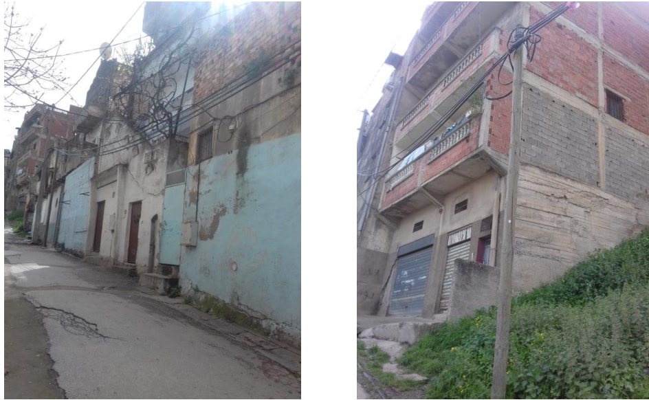
Figure 3.7 : Partie de la rue de Braham la moins touchée par le glissement de terrain
