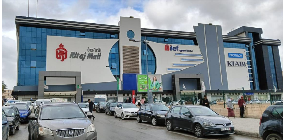
Figure 4.10 : La façade principale du Ritaj mall
