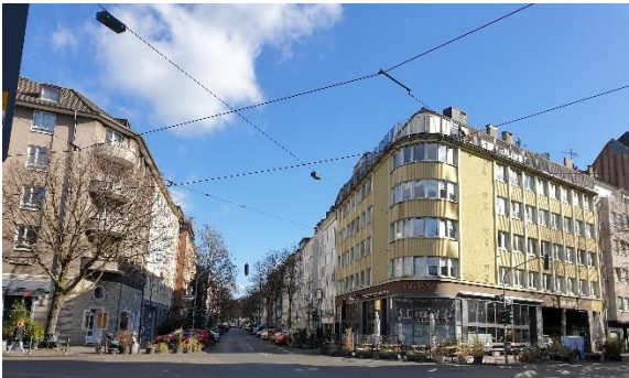
Corner of Ackerstraße and Lindenstraße Café Hüftgold on the right corner.
