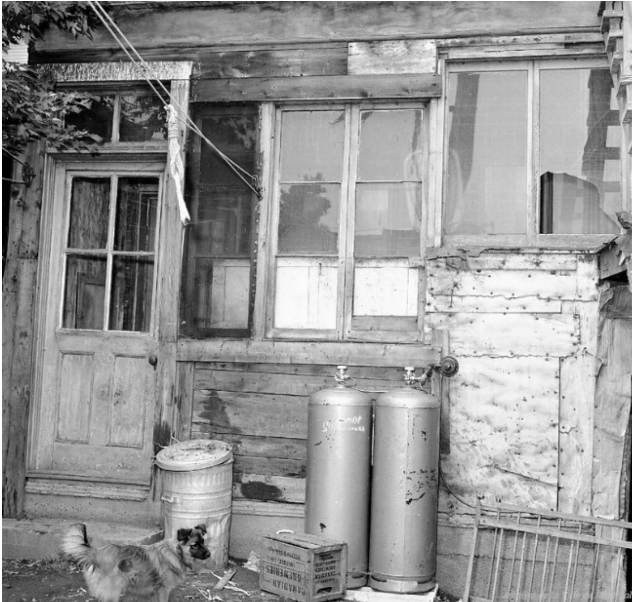
Figure 114 : Arrière d'un logement à Victoriatown (Goose Village)
