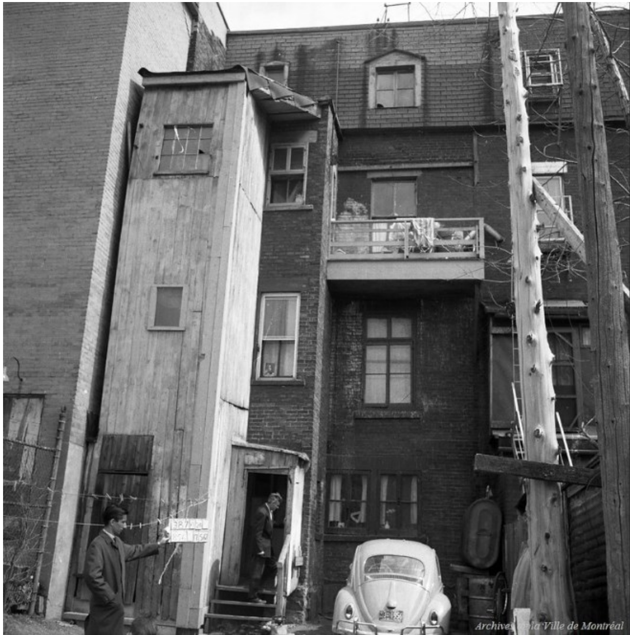
Figure 102 : Arrière d'un immeuble à logements dans la Petite-Bourgogne sur le point d'être démolie car identifiée comme taudis. On voit vers la gauche de l'image le hangar dans lequel sont remisés les combustibles
