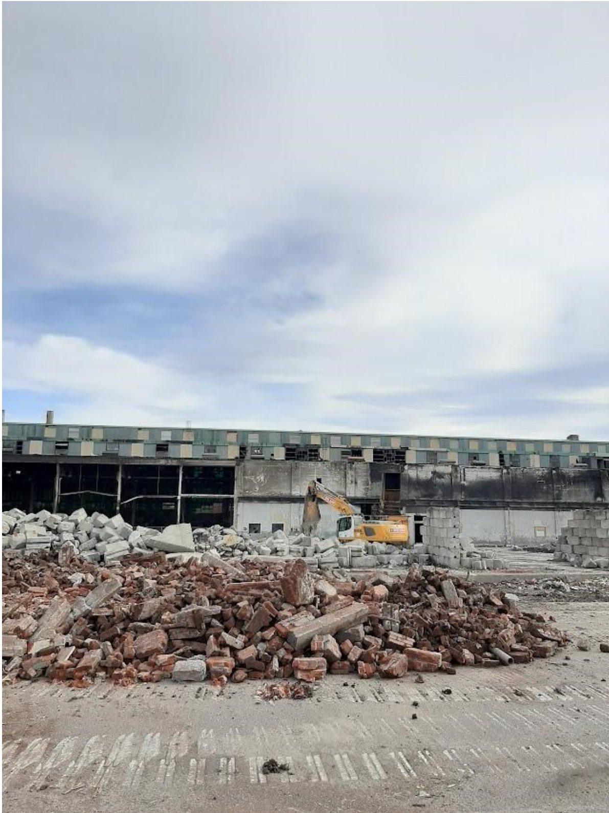
Figure 77 : Usine en démolition sur la rue Sherbrooke à Montréal-Est Source : Hatton-Proulx 2022
