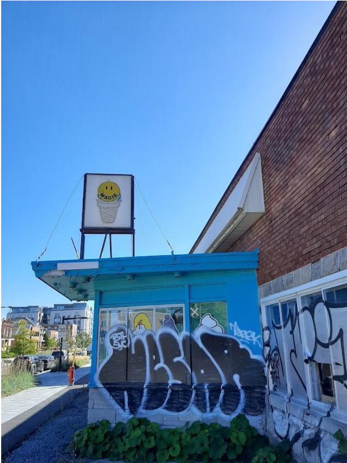
Figure 72 : Ancien commerce abandonné sur l'avenue Broadway, originellement la principale artère commerciale de Montréal-Est
