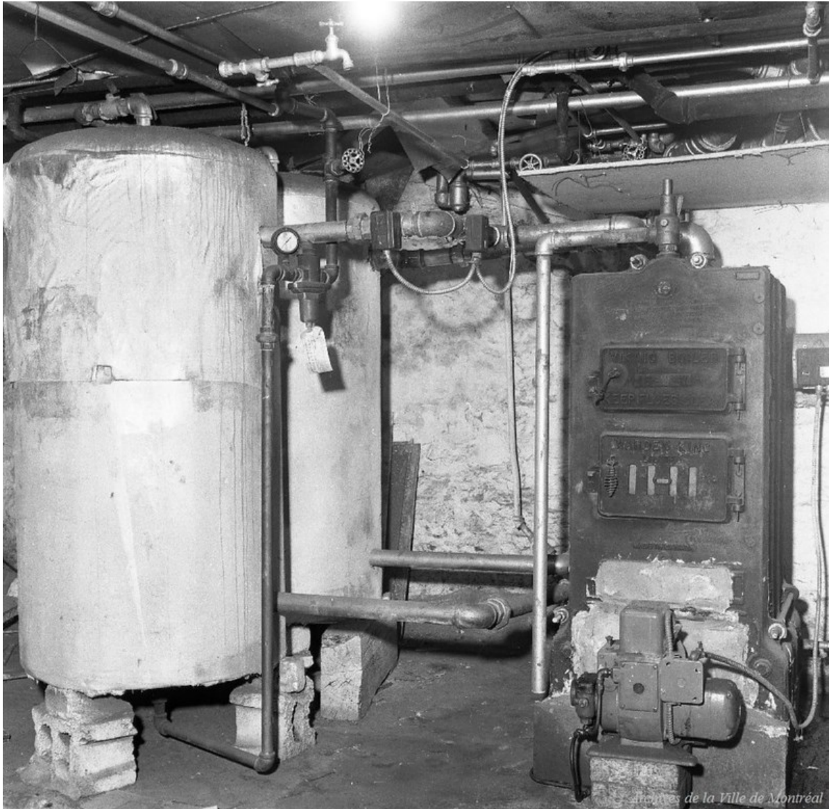
Figure 115 : Sous-sol d'un immeuble résidentiel de la rue Winning avant sa démolition Source : Photographie de Florent Charbonneau, Archives de la Ville de Montréal 1959, P158-Y-2_06P004
