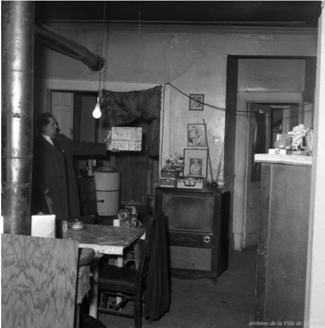
Figure 107 : Intérieur du 826 rue Saint-Martin dans le quartier de la Petite-Bourgogne avec son filage électrique hasardeux
