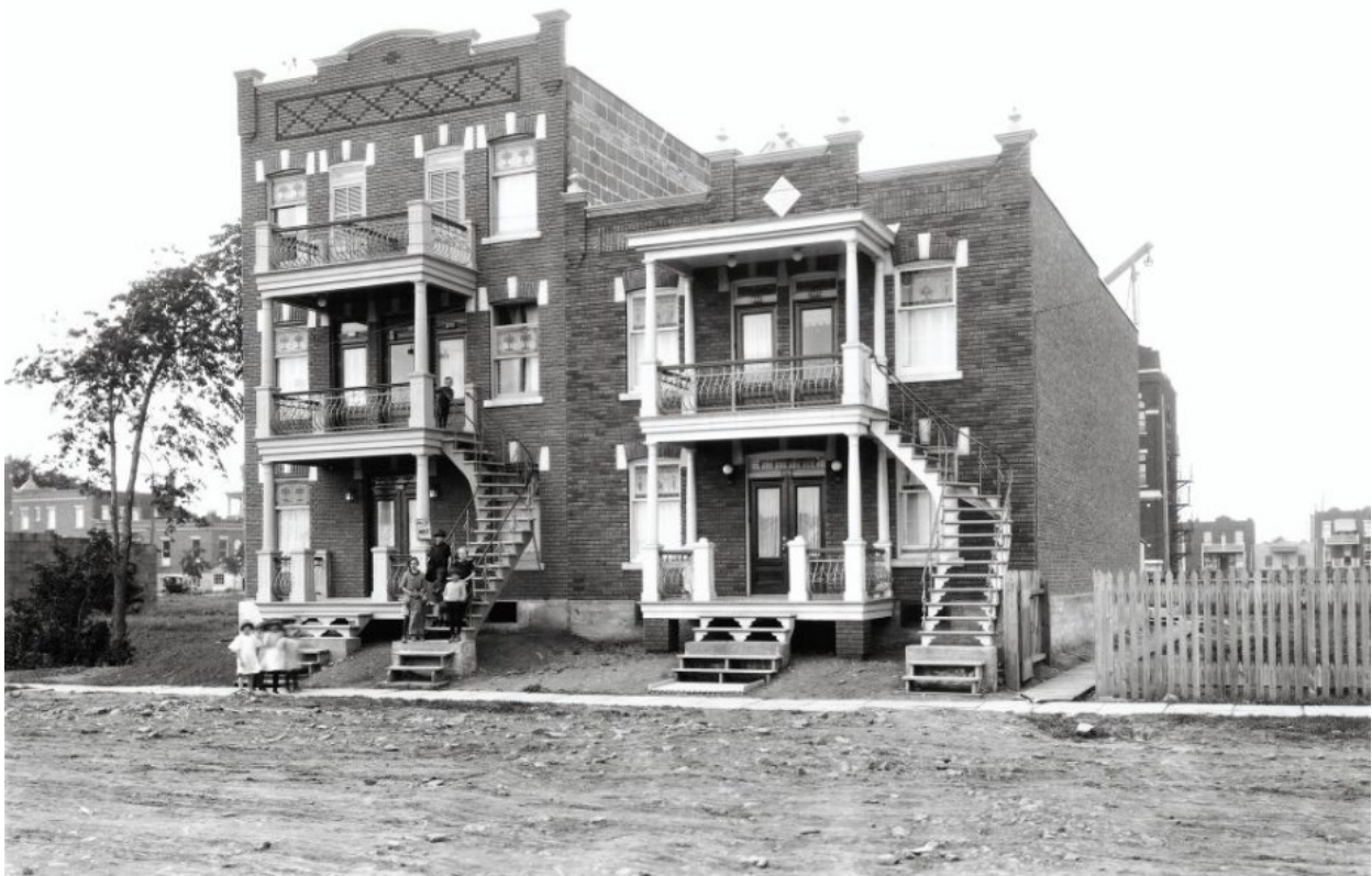
Figure 99 : Exemple d'un triplex (gauche) et duplex (droite) relativement cossus construits dans le quartier montréalais de Rosemont. Les espaces libres de chaque côté seront vite comblés par d'autres plex dans les années suivantes Source : Photographie par William Notman & Son, Archives du Musée McCord 1925
