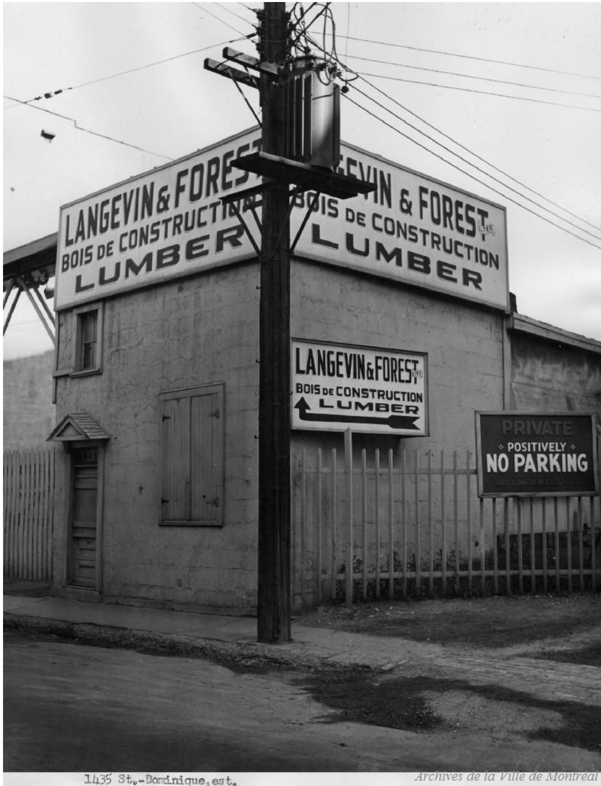
Figure 16 : Cour à bois de construction au 1435 rue Saint-Dominique dans le secteur du Red Light District
