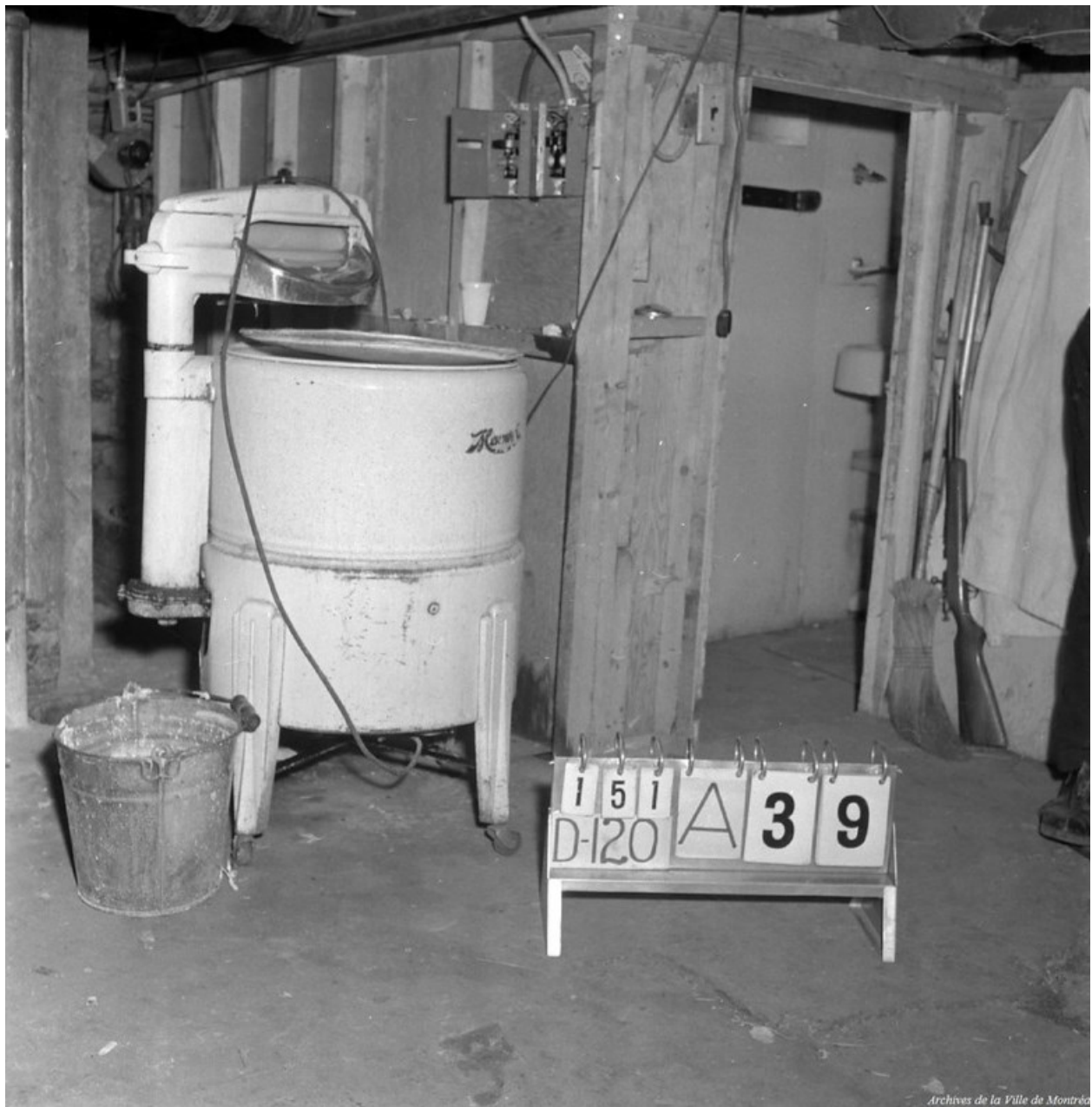
Figure 109 : Sous-sol d'un immeuble à logements avec machine à laver manuelle de type lessiveuse, secteur de l'autoroute Ville-Marie
