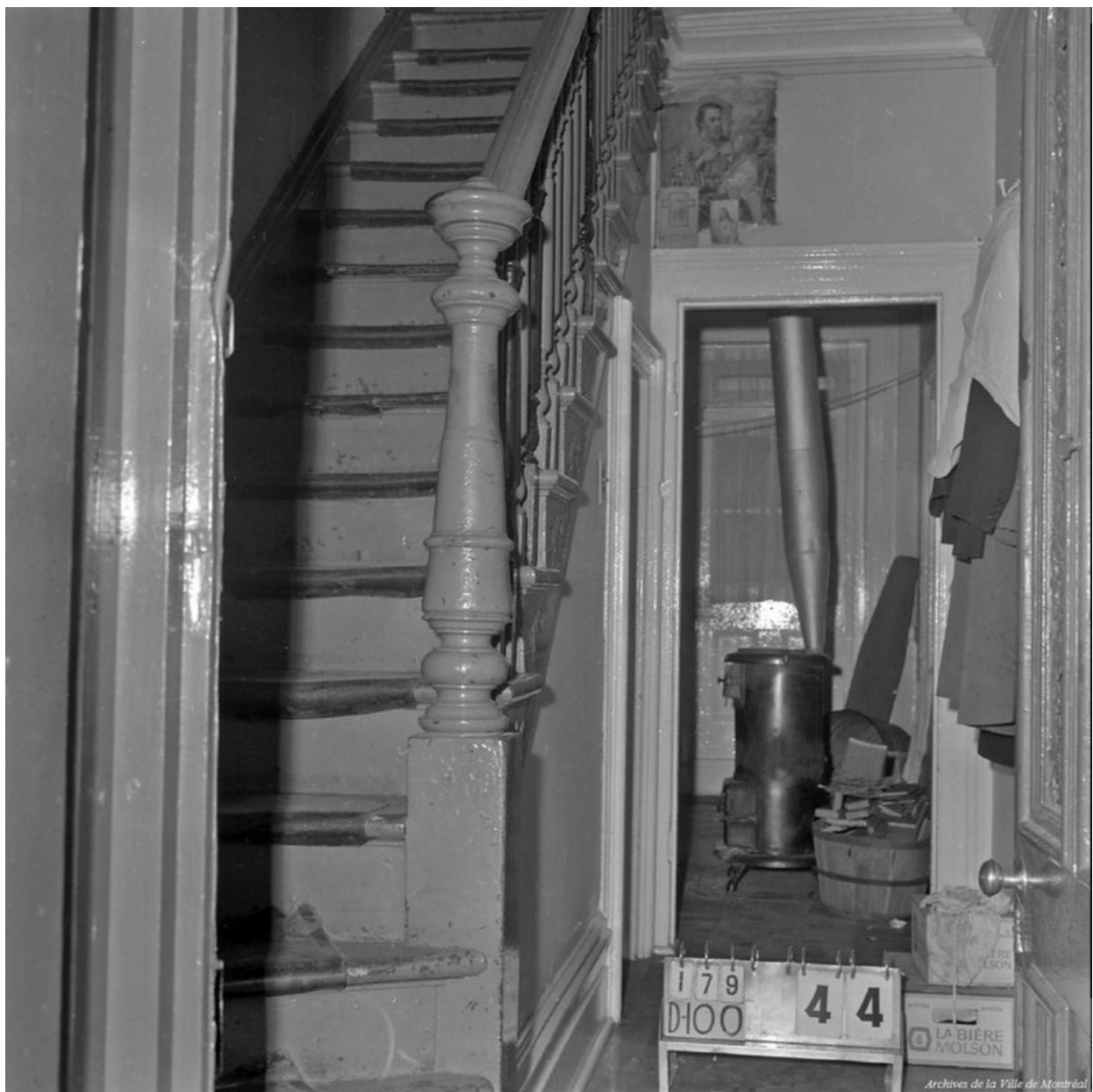
Figure 106 : Intérieur d'un immeuble d'appartements à Victoriatown (Goose Village). On devine que le poêle est alimenté au bois
