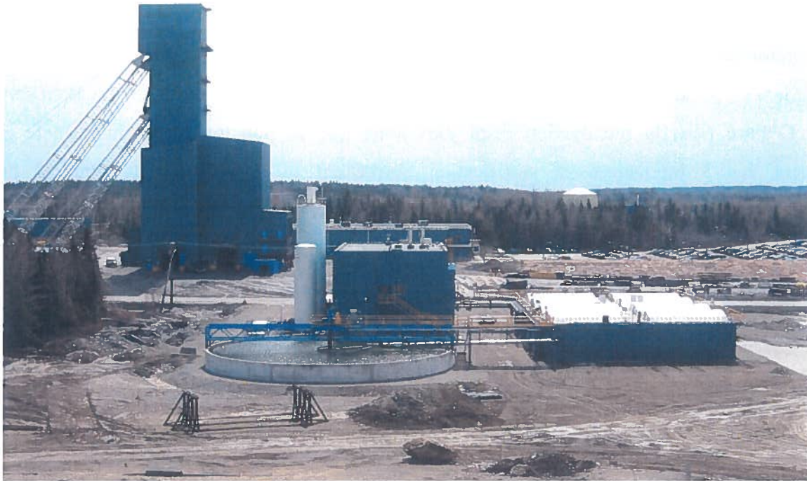
Figure 2.2 : Photo représentative de l'emplacement de l'UTFE avant la construction de deux lignes supplémentaires. Nous y retrouvons le bâtiment abritant le laboratoire, les réservoirs de mélange, les soufflantes, les préparations des réactifs, les cuves en béton contenant les biodisques, le clarificateur, le silo de soude caustique et le réservoir de CO 2 .
