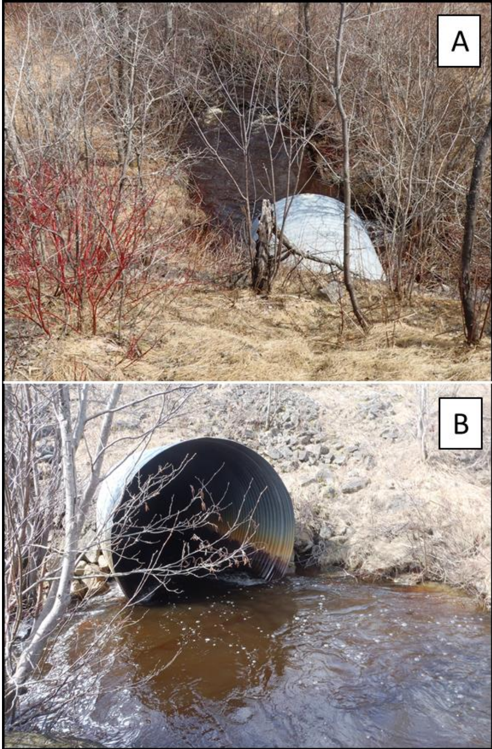
Figure P.3 - Exutoire du site S3. A : Rivière La Chevrotière en amont du ponceau sur la route du Moulin; B : Cours d'eau en aval de la station et à l'entrée du ponceau (Photos : Samuel Bolduc).
