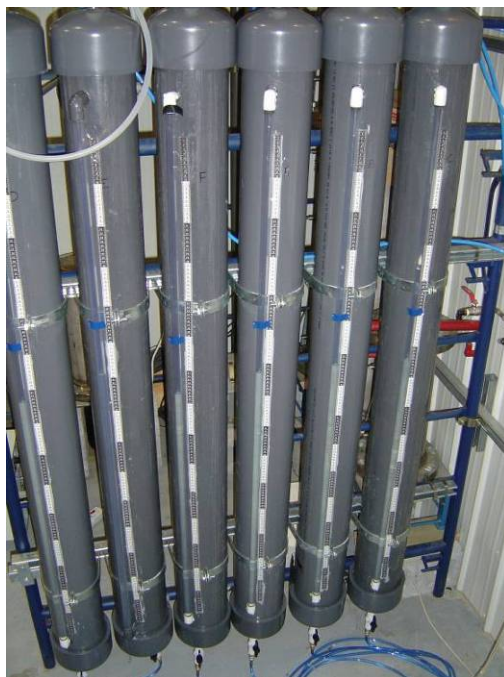
Figure 43. Réservoir d'eau distillé alimentant les colonnes
