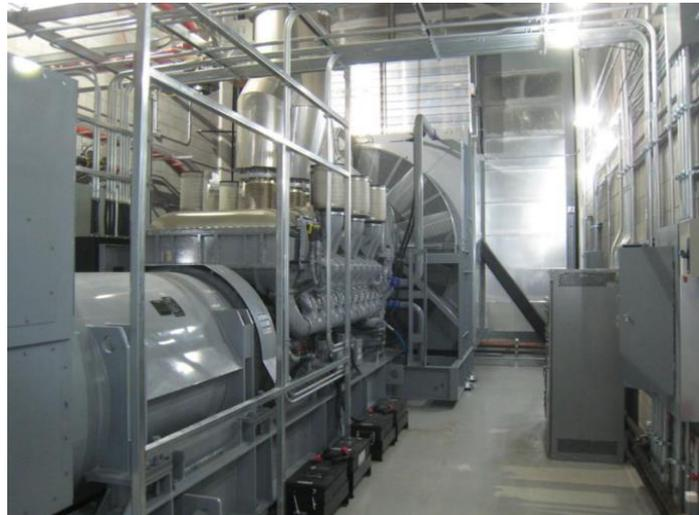
Figure 42 MTU 3.3MW génératrice installée dans le bâtiment de MTL2
