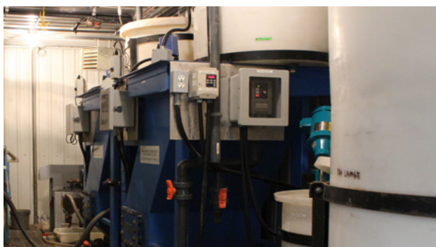
Décanteurs lamellaires avec instrumentation
