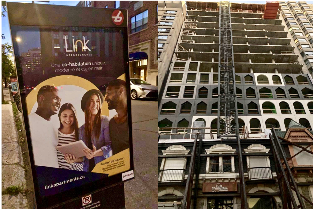
Figure 24. Le projet de 127 logements en cohabitation haut de gamme Link en cours de construction sur l'avenue Lincoln près de la rue Saint-Mathieu
