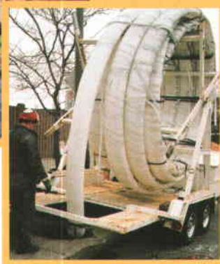
Réhabilitation d'une conduite d'égout à l'aide d'un tuyau déformé.
