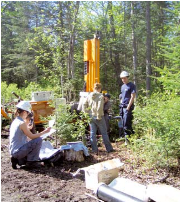
Sondage des propriétés mécaniques du sol à l'aide d'un pénétromètre et installation de piézomètres pour la détection du panache de lixiviat à l'ancien site d'enfouissement sanitaire de Saint-Lambert-de-Lauzon.
