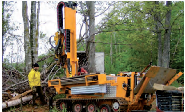
Foreuse Geotech sur le terrain
