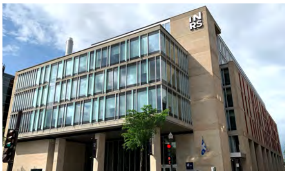
Édifice INRS au centre-ville de Québec
