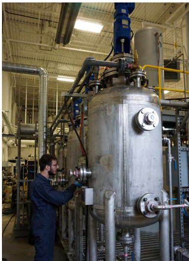
Unité de démonstration de procédés de carbonatation minérale
