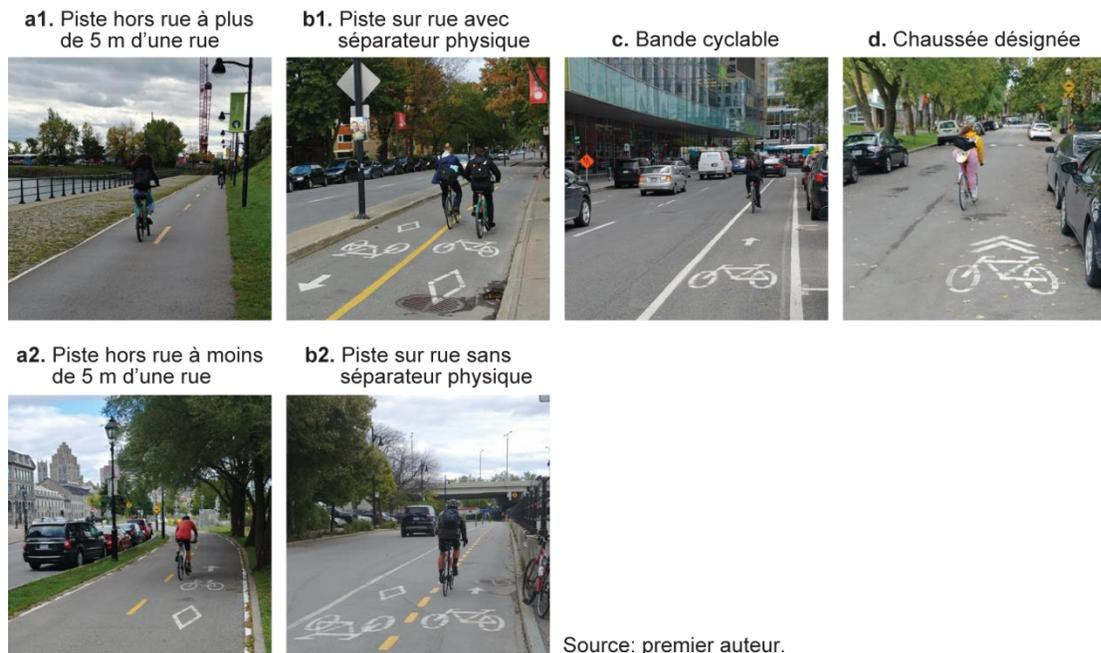
**Figure 3.2 Illustration des quatre types de voies cyclables.**
