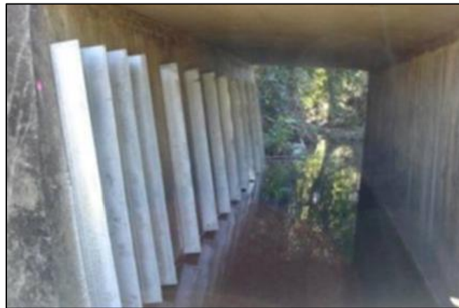
Figure 4.5 Ponceau équipé de cloisons latérales (issu de O'Connor 2017)
