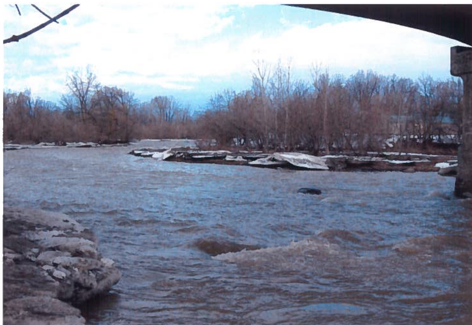
Site 1 : Rivière Achigan, village de St-Roch-de-L'Achigan
