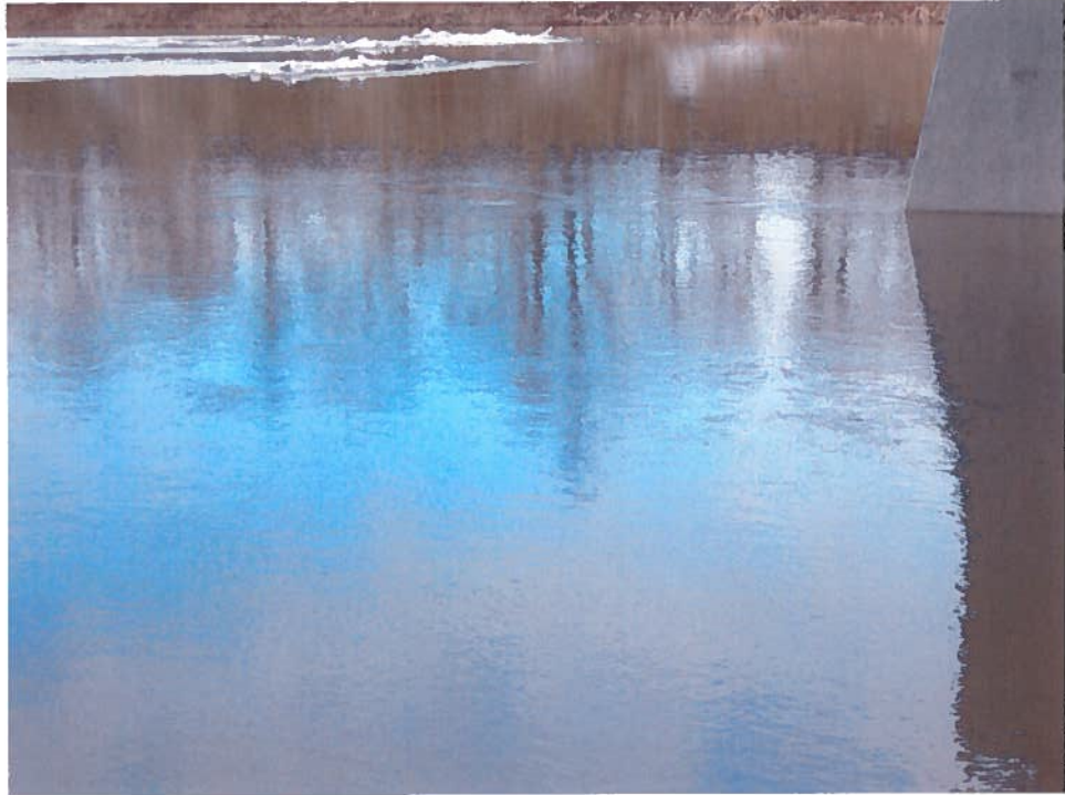
Site 2 : Rivière L'Assomption, pont de la 341
