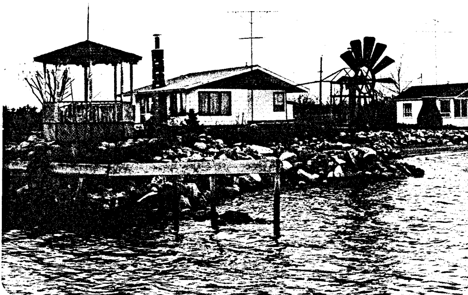
PHOTO 1 LE BAUME, PARTIE CENTRE - Chalet bien entretenu et de valeur plus élevée que la moyenne. Petit mur de pierres servant de protection contre les inondations.
