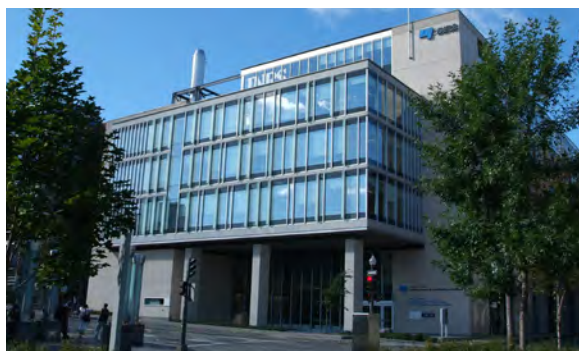
Édifice INRS au centre-ville de Québec
