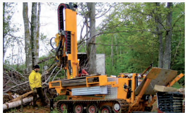
Foreuse Geotech sur le terrain
