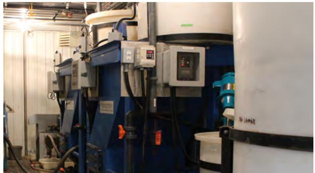
Décanteurs lamellaires avec instrumentation
