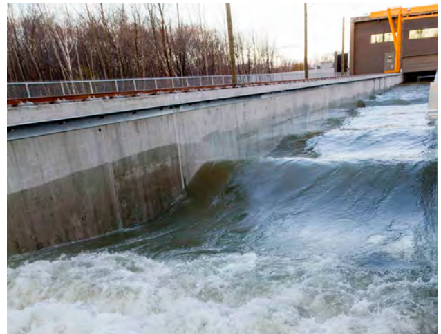
Canal hydraulique (© Denis Bernier)
