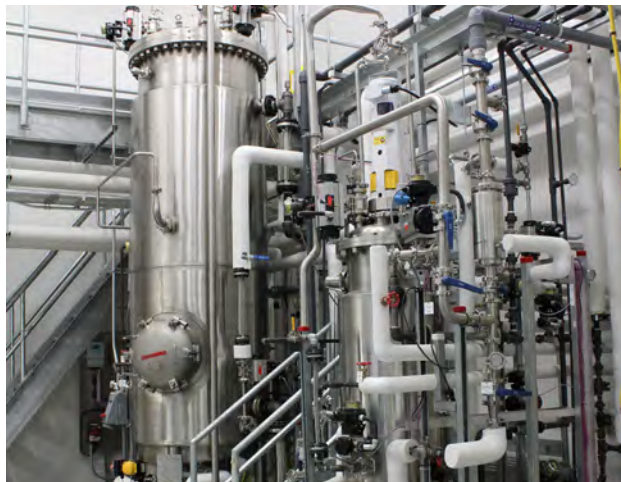
Hydrolyseurs de 150 et de 2000 litres
