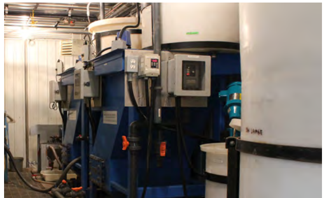
Décanteurs lamellaires avec instrumentation
