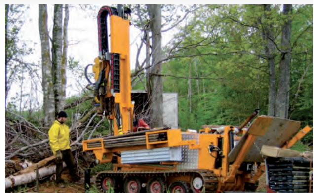
Foreuse Geotech sur le terrain
