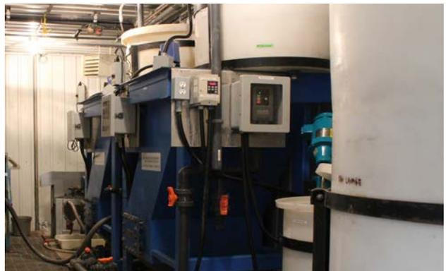
Décanteurs lamellaires avec instrumentation
