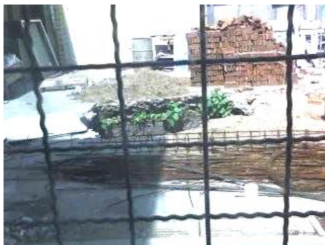
Photo 13 : École primaire 30, travaux de réparation abandonnés
