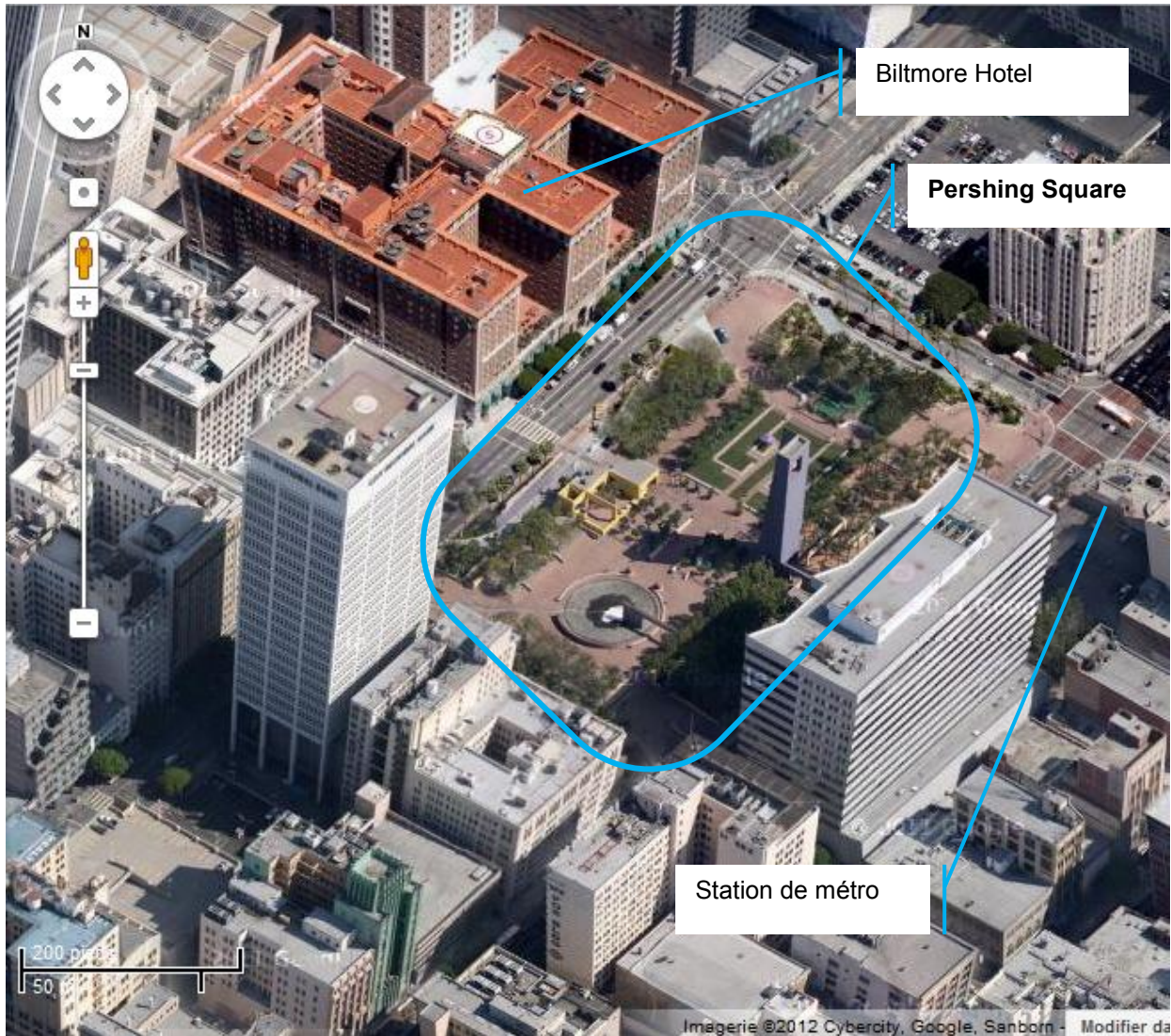
Figure 17 : Pershing Square vu du ciel
