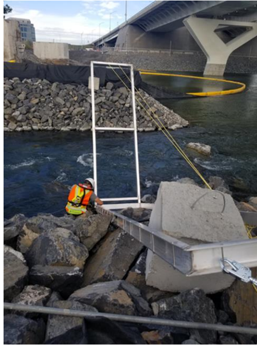
Figure 6. Antenne de détection des PIT-tag de type « pass-over ».
