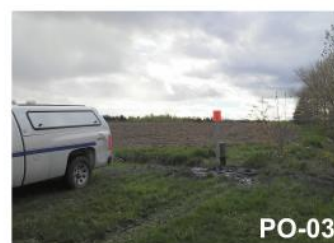
- Compton - Puits finalisé et équipé (MELCC - 21 mai 2019)
