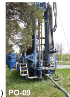
- Val-Joli - Travaux de forage (COGESAF - 23 mai 2019)
