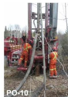
- Weedon - Travaux de forage (MELCC - 15 mai 2019)
