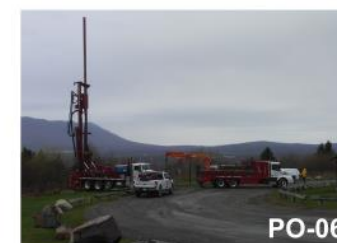
- Notre-Dame-des-Bois - Travaux de forage (MELCC - 17 mai 2019)
