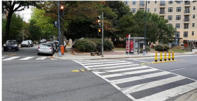
Figure 9 : Implantation d'une ligne centrale avec entrave
