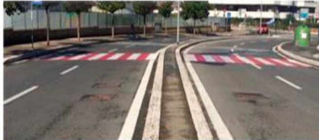
Figure 8 : Passages piétons pavés zébrés rouge et blanc
