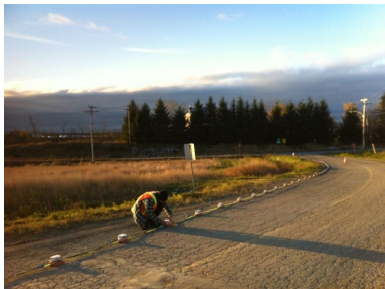
Figure 15 : Photo des capteurs à trois composantes des ondes sismiques
