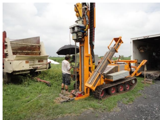
Figure 8 : Travaux de forages avec la foreuse Geotech 605D de l'INRS
