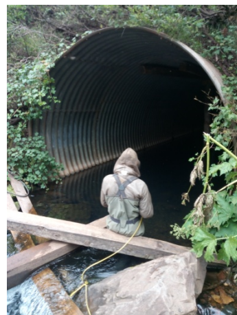
Vue aval du ponceau
