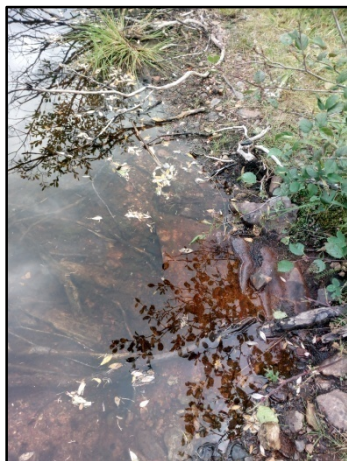
Vue aval du ponceau
