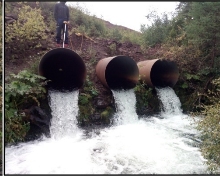
Vue aval du ponceau
