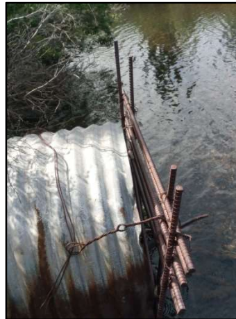
Vue amont du ponceau
