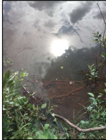
Vue aval du ponceau
