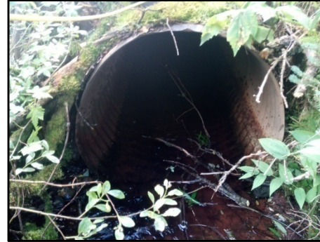
Vue amont du ponceau
