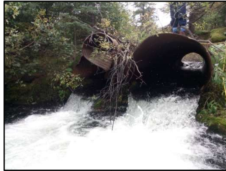
Vue aval du ponceau
