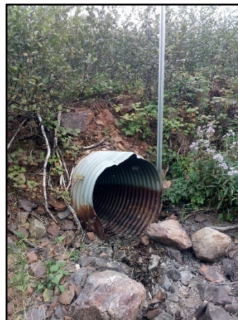
Vue amont du ponceau
