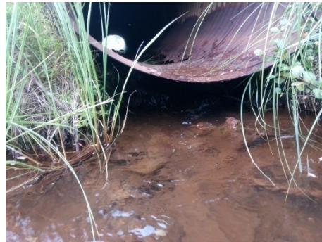
Vue aval du ponceau
