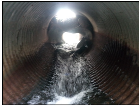
Vue aval du ponceau
