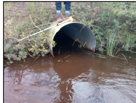
Vue amont du ponceau
