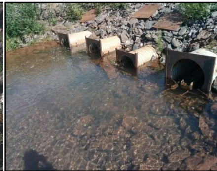
Vue amont du ponceau
