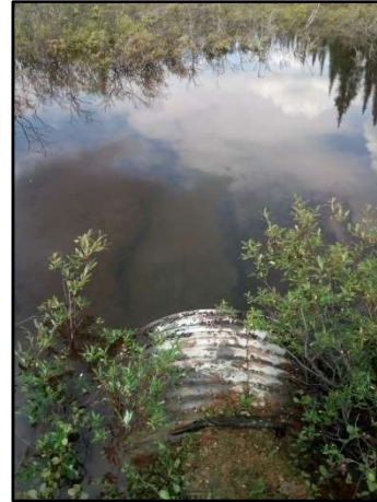
Vue amont du ponceau
