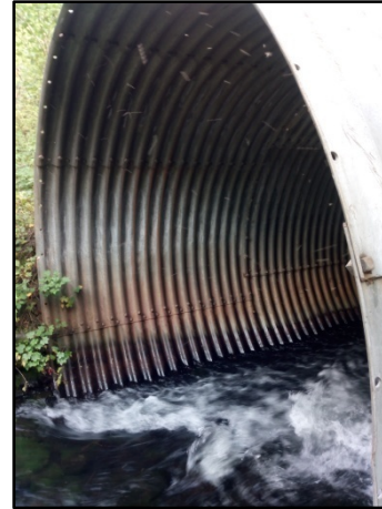
Vue amont du ponceau
