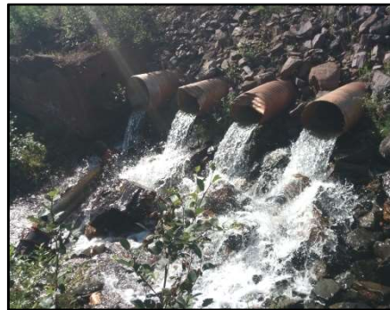
Vue aval du ponceau
