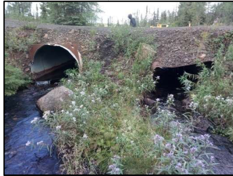
Vue aval du ponceau
