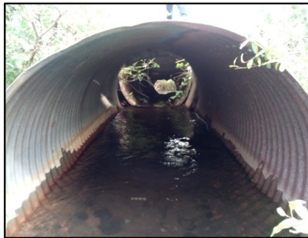
Vue amont du ponceau
