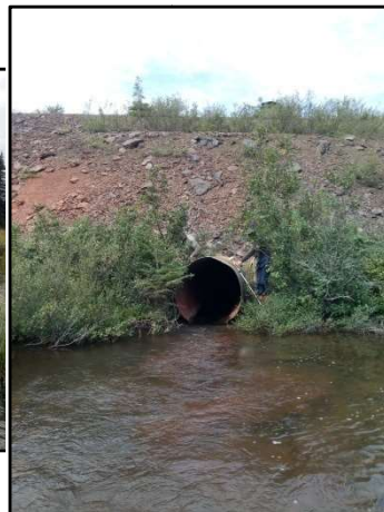
Vue aval du ponceau
