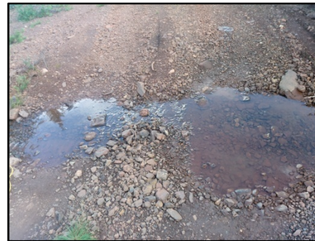
Vue amont du ponceau
