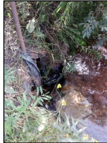
Vue amont du ponceau
