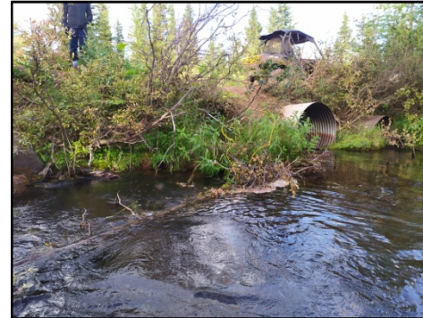
Vue amont du ponceau
