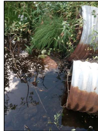
Vue amont du ponceau
