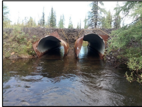
Vue aval du ponceau
