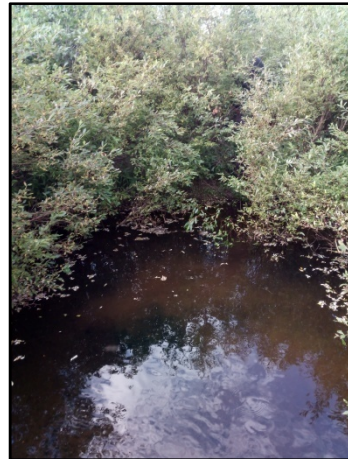
Vue aval du ponceau
