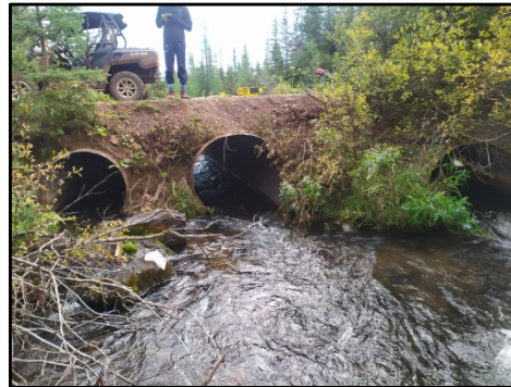
Vue aval du ponceau
