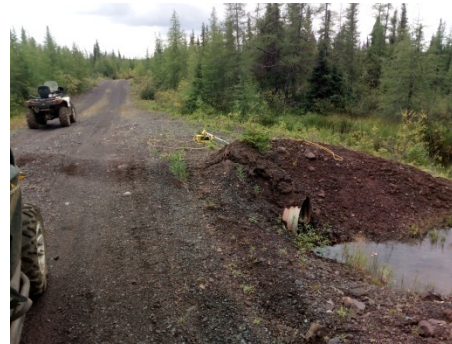
Vue amont du ponceau
