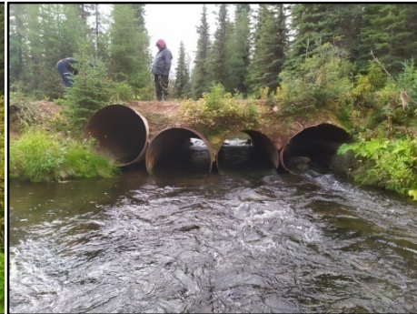
Vue aval du ponceau
