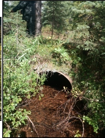
Vue aval du ponceau
