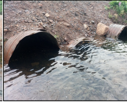
Vue amont du ponceau
