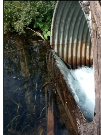
Vue amont du ponceau
