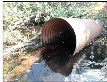
Vue amont du ponceau
