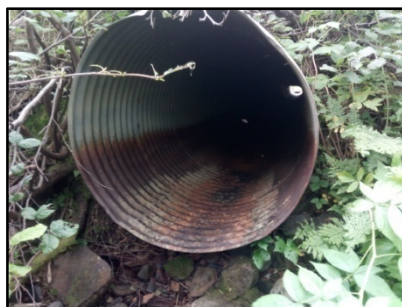
Vue aval du ponceau
