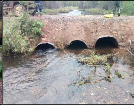
Vue aval du ponceau
