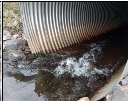
Vue amont du ponceau
