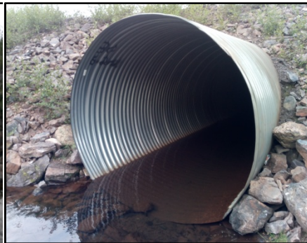
Vue aval du ponceau
