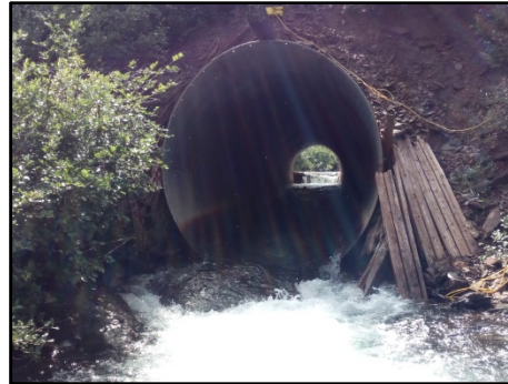
Vue aval du ponceau
