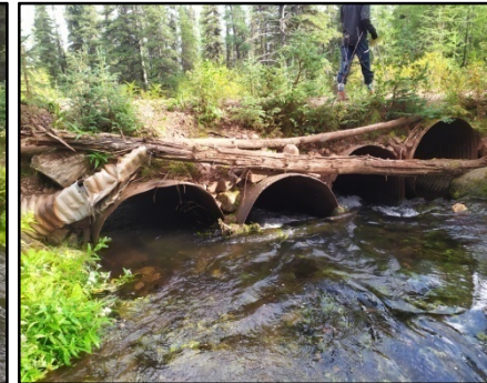
Vue amont du ponceau
