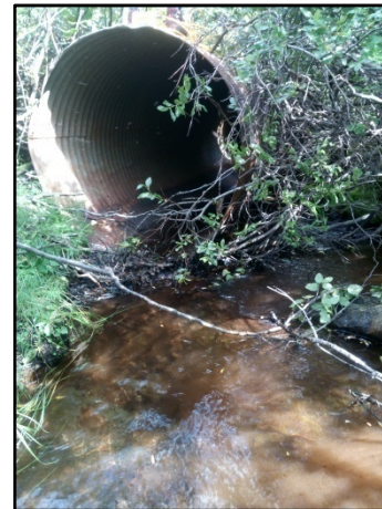
Vue amont du ponceau
