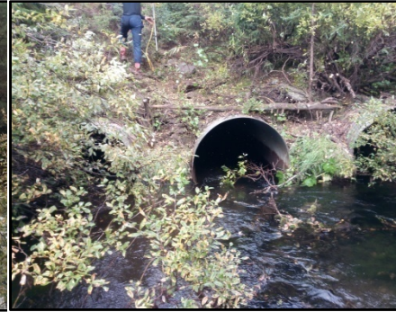
Vue amont du ponceau
