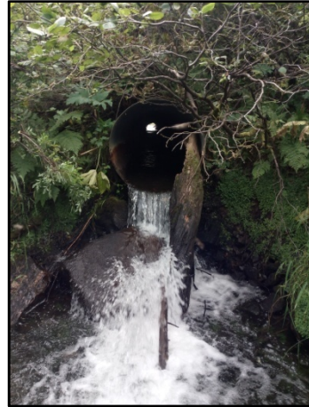
Vue aval du ponceau
