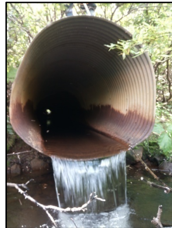
Vue aval du ponceau
