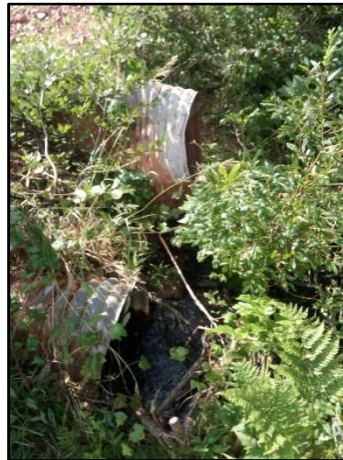
Vue aval du ponceau
