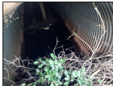
Vue amont du ponceau
