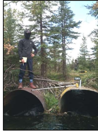
Vue amont du ponceau
