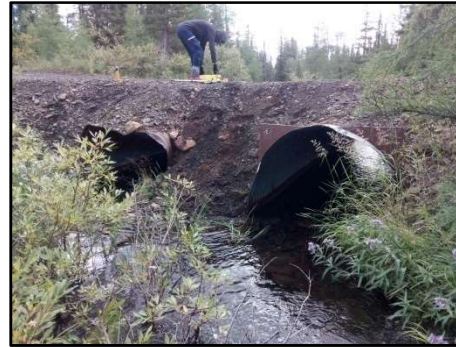
Vue amont du ponceau
