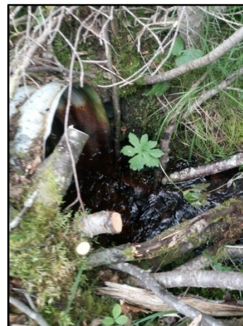
Vue amont du ponceau
