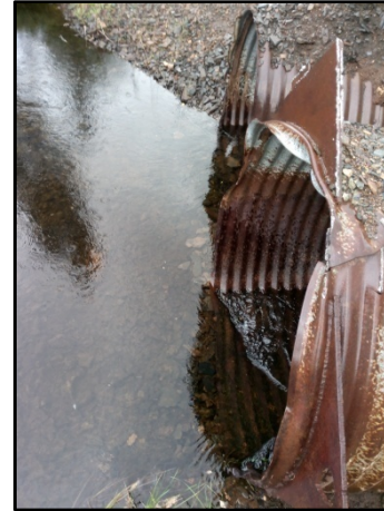
Vue amont du ponceau
