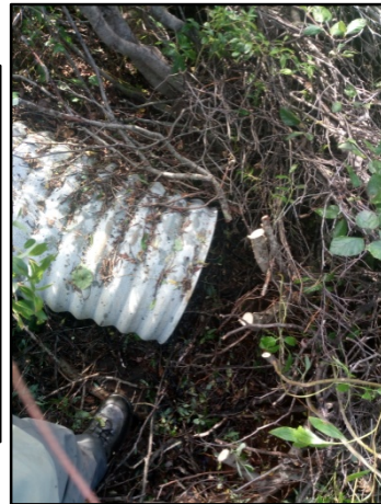
Vue aval du ponceau
