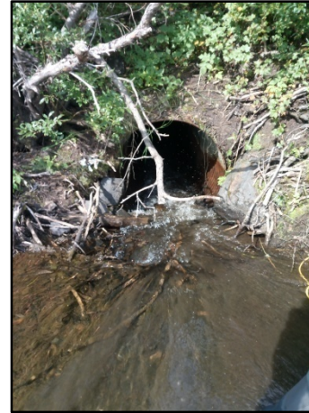
Vue amont du ponceau
