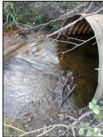
Vue aval du ponceau
