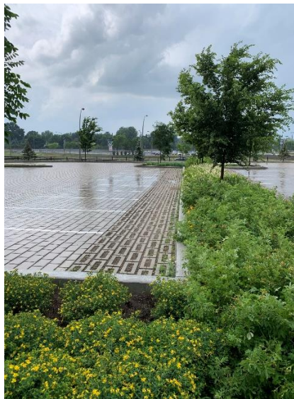
Figure 3.2 Vue d'une cellule de biorétention, du pavage alvéolé et du pavage perméable
