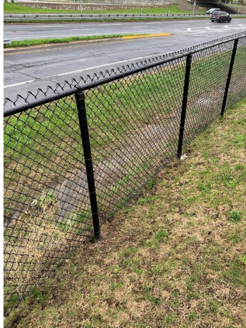
Figure 3.16 Vue du fossé et de l'autoroute 132 à partir du site
