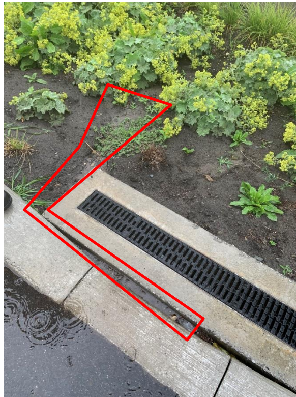
Figure 4.19 Contournement du bassin de stockage des sédiments par les eaux de ruissellement entrant dans une cellule de biorétention (la délimitation en rouge représente le chemin des eaux de ruissellement)
