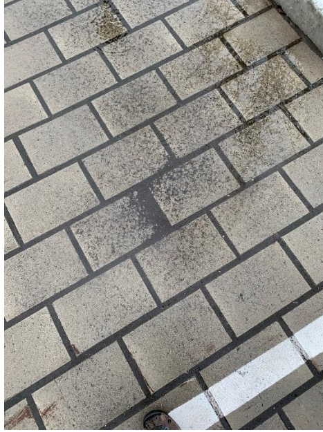
Figure 4.25 Accumulation et transport des sédiments sur le pavage perméable imperméabilisé durant un évènement de pluie
