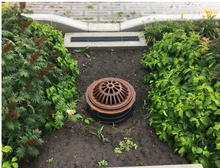
Figure 3.10 Puisard de trop-plein dans une biorétention
