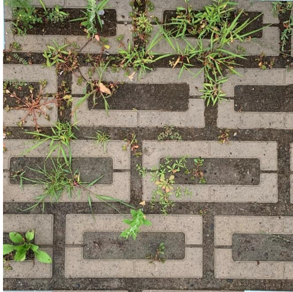
Figure 4.14 Pavage perméable au site #3 le 8 juillet 2021
