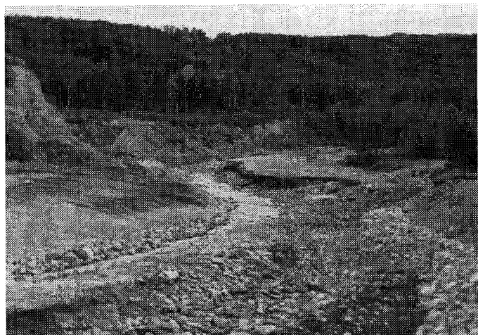
Érosion latérale des berges et incision du lit de la rivière des Ha! Ha! dans le secteur situé en amont du barrage Stone 2.
