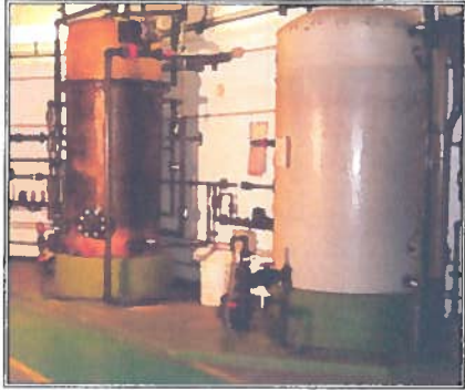
Figure 1.3. Photos du système de dénitrification du Biodôme de Montréal. (A) Désoxygénateur (à droite) et dénitrificateur (à gauche); (B) Photo d'une biobille de type Bioflow 9 ® sur laquelle s'est développé un biofilm.
