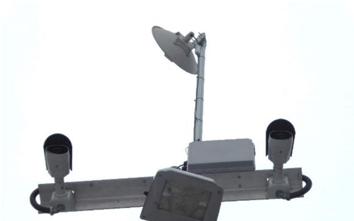
Figure 3.2 : Dispositif de surveillance sur le site nord à Saint-Jean-sur-Richelieu
