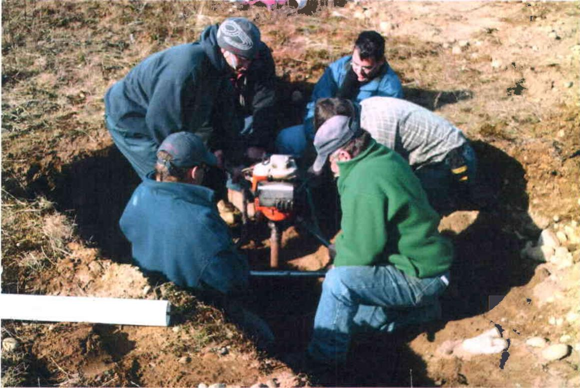
Figure C4 : Excavation à la tarière mécanique pour l'installation d'un lysimètre passif
