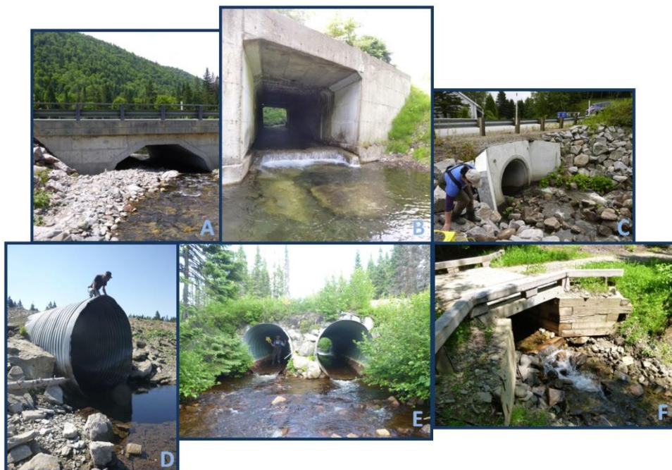
Figure 1. 1 : Différents types de ponceaux : en béton armé en forme d'arche (A), de boîte (B) ou circulaire (C) ; circulaire en tôle ondulée galvanisée simple (D) ou multiple (E) ; rectangulaire en bois (F).
