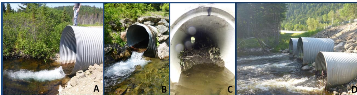
Figure 1. 2 : Exemples de conditions pouvant rendre le ponceau partiellement ou complètement infranchissable par le poisson : la constriction du cours d'eau (A) ; la présence d'une chute située à l'extrémité aval du ponceau (B); l'obstruction du ponceau par des débris végétaux et/ou des sédiments (C), vitesse de l'écoulement excessive (D).
